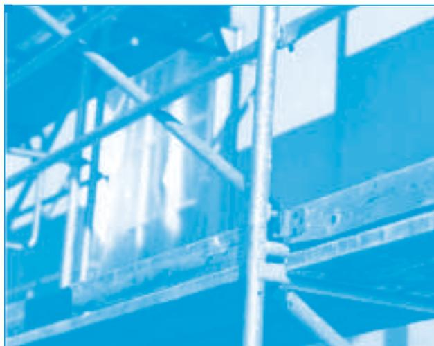
Les sollicitations exercées sur un échafaudage par un auvent — charge permanente, charge dynamique et charge du vent — sont en général très importantes; par conséquent, ces charges doivent être prises en compte lors du choix de l'échafaudage.
